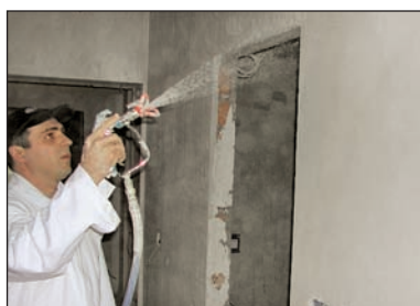
Precizno nanošenje pomoću pištolja.
