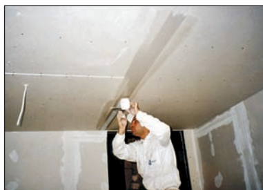
Bandažna traka utiskuje se u ispunjivač.
