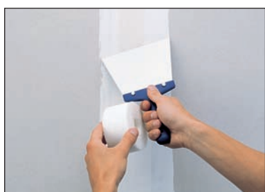
Utiskivanje staklene bandažne trake u nanjeti sloj ispune.
