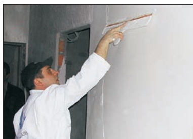
Gletanje širokim gleterom do perfektne glatkoće.
