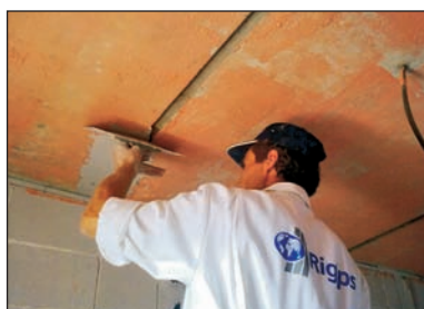
Ispunjavanje betonskih spojeva.
