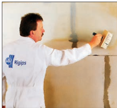
Impregniranje podloge od poro-betona Rikombi-Grundom.
