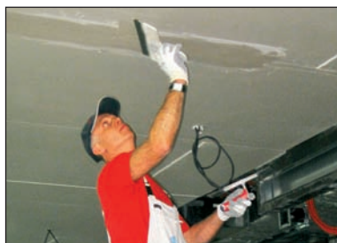
Nanošenje drugog sloja ispune preko bandažne trake.
