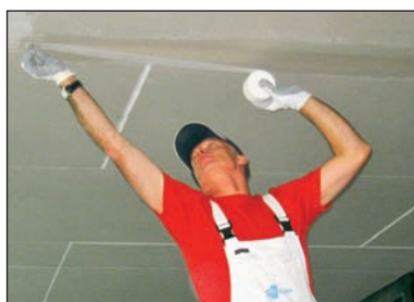
Postavljanje bandažne trake na prvi sloj nanijete ispune Vario.
