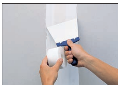
Utiskivanje staklene bandažne trake u nanjeti sloj ispune.
