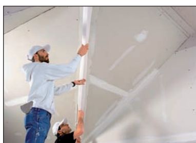
Ugradnja Ultra-Flex trake.
