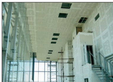
Površina gipskartonskih ploča obrađena u kvaliteti Q1.
