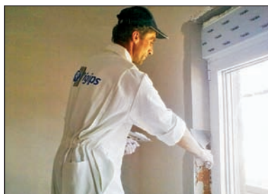
Obrada špaleta (otvora).
