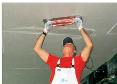
Gletanje cijele površine ploča Variom u kvaliteti Q3.
