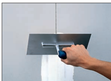
Ispuna spojeva gipskartonskih ploča.
