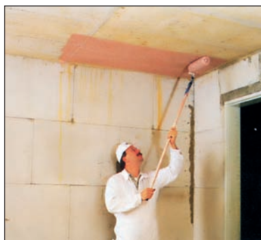
Impregniranje betonske podloge Rikombi-Kontaktom.
