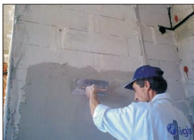
Nanošenje materijala u jednom sloju.
